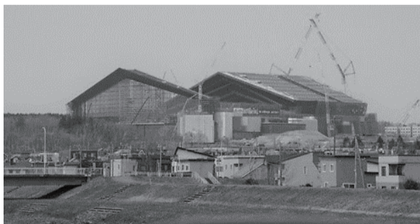
建設中の北海道ボールパークFビレッジ
